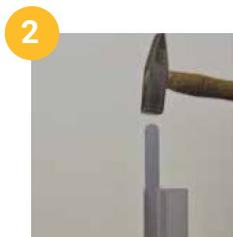
2 Insérer le support pour pénétrer jusqu'à 10/15mm le point de serrage
